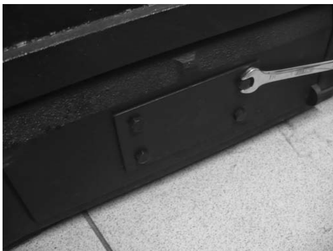
1. Odkręcić zaślepkę z klapy uchylnej dolnych drzwiczek kotła.
