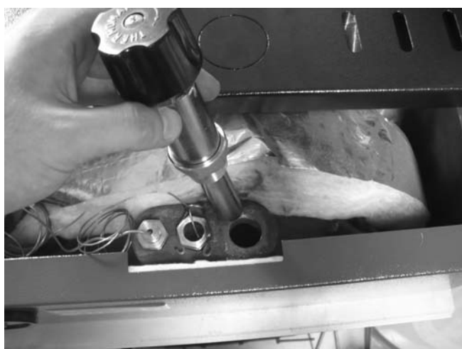
4. W miejsce korka wkręcić szczelnie miarkownik ciągu.
