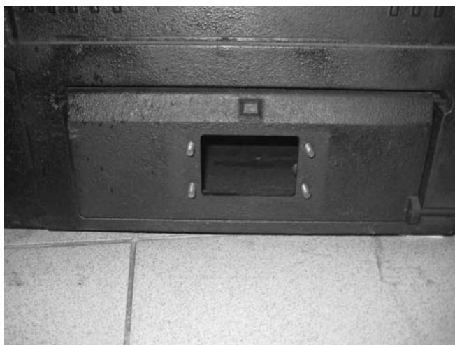
2. Włożyć 4 śruby M5 z podkładkami (dołożone do kompletu wentylatora).
