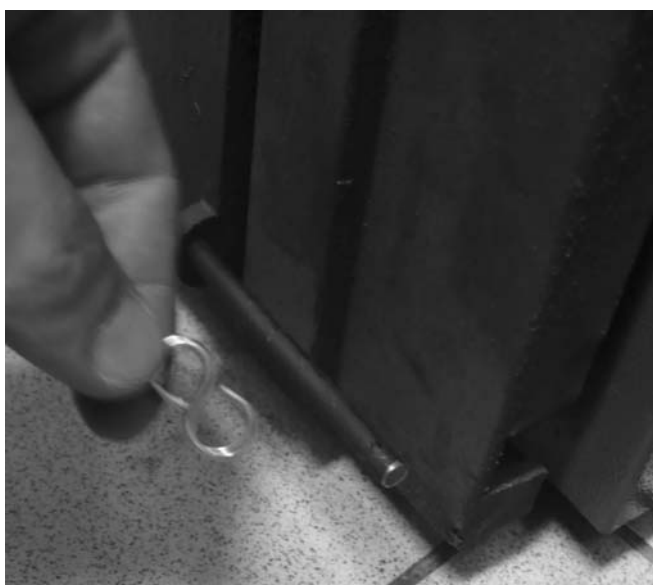
7. Dolny koniec łańcuszka połączyć z uchylną klapą dolnych drzwiczek.
