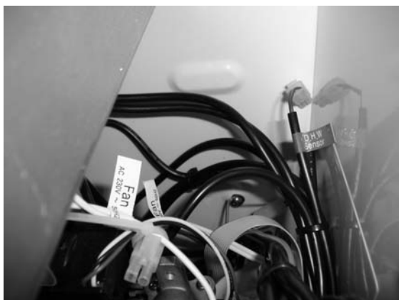
13. Odkręcić przewód uziemienia.
