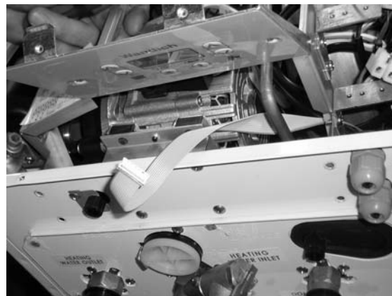
9. Odkręcić mocowanie panelu od obudowy kotła i wyjąć je z kotła.
