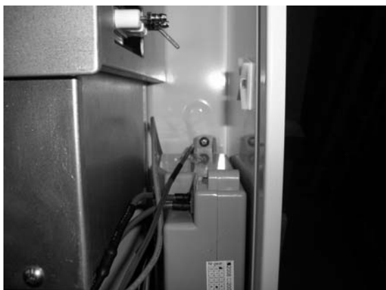
11. Odkręcić automatykę od obudowy kotła.
