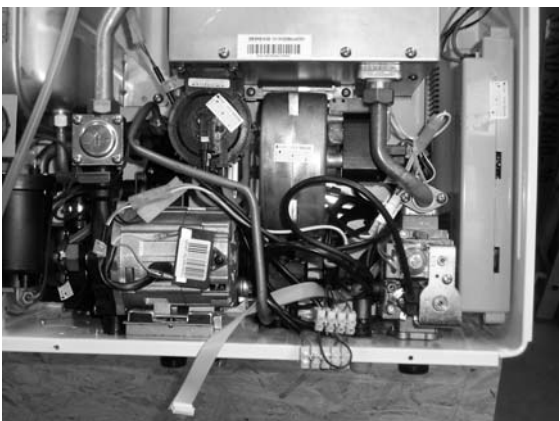
8. Odkręcić kostkę wysokonapięciową od mocowania panelu.
