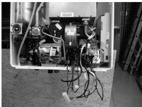
13. Odkręcić przewód uziemienia.
