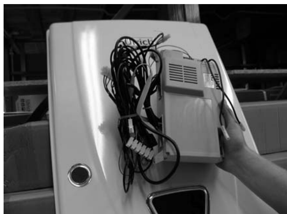
14. Włożyć nową automatykę do kotła.
